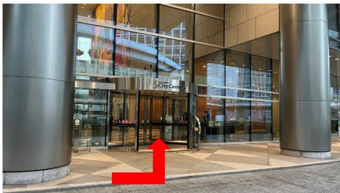
日本テレビタワー側 地上、オフィスロビー入口
